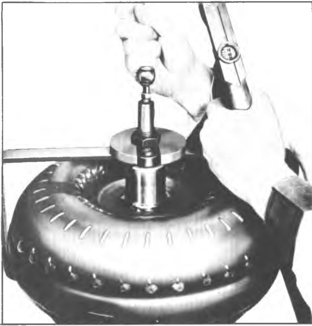
Fig. 7A-138C--Air Checking Converter
